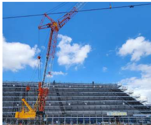
2026.8.7@令和あらかわクリニック工事現場
